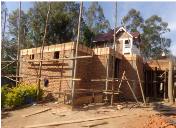
Photos: bâtiment polyvalent en construction
