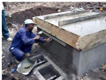
construction d'un réservoir
